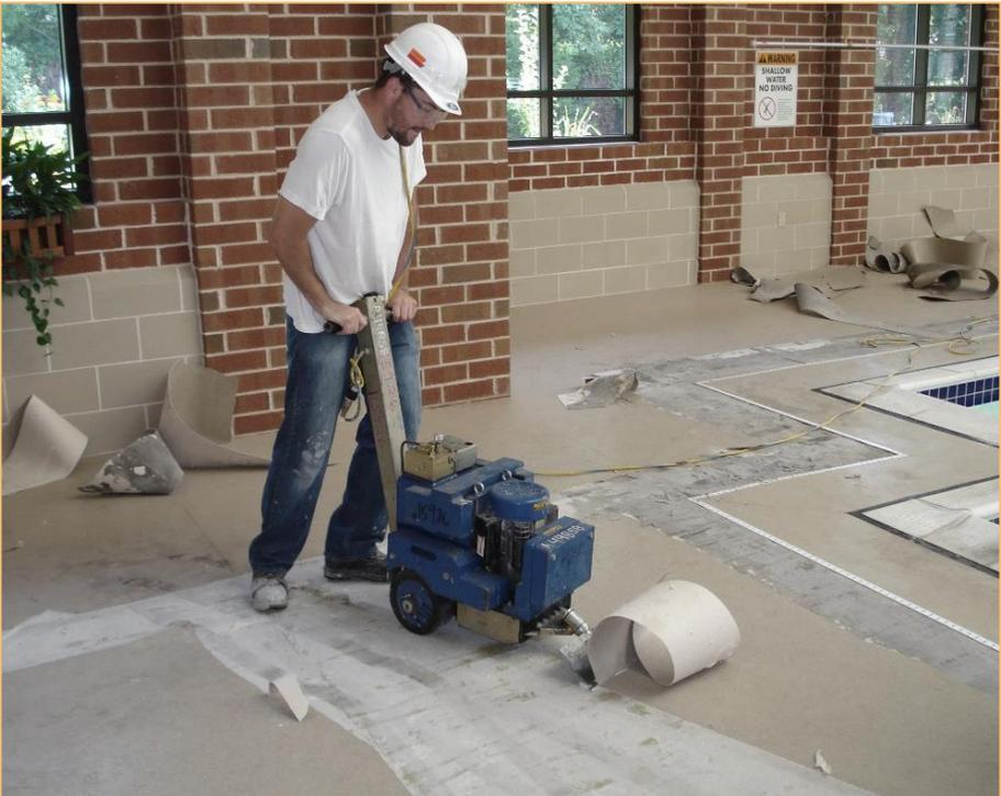
آماده سازی سطح عامل بسیار مهمی در نصب موفق یک سیستم پوشش محافظتی است. سطح مورد نظر بایستی از نظر وجود نواقص سطحی، ترک‌ها، نقاط ضعف و آلودگی‌های سطحی مورد بازرسی قرار بگیرد. روغن، چربی، مواد شیمیایی و سایر آلاینده‌های بایستی قبل از آماده سازی سطح از آن پاک شوند. به این منظور می‌توان از مواد شوینده‌ی مخصوص، آب با فشار کم یا شستشوی بخار استفاده نمود. نقاط ضعیف، تخلخل سطح و ترکیبات شیمیایی لایه‌ی رویه‌ی سطح بتن از سطح جدا شوند.
